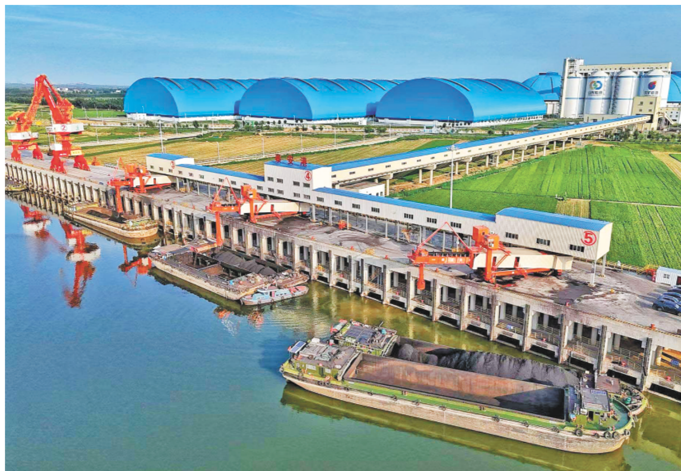
泰安港老湖作业区集装箱作业现场。
