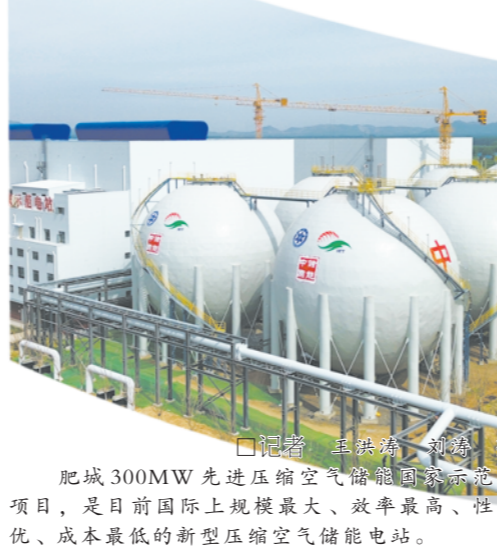
□记者 王洪涛 刘涛 报道 肥城300MW先进压缩空气储能固液示范电站项目,是目前国际上规模最大、效率最高、性能最优、成本最低的新型压缩空气储能电站。
