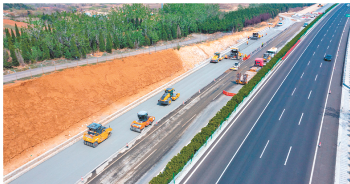
“五一”假期，由山东高速集团投资建设的荣乌高速烟台枢纽至蓬莱枢纽改扩建工程不停工。截至目前，项目累计完成投资64.19亿元，路基工程完成97.8%，路面工程完成66.5%，桥涵工程完成95.1%。
