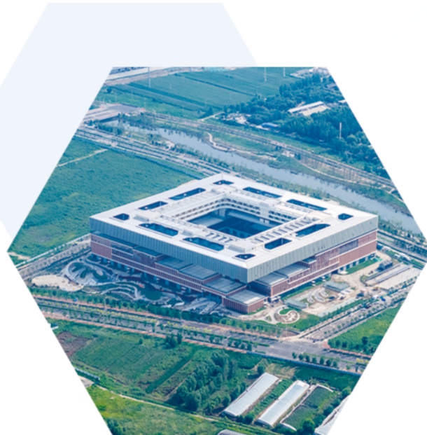
平行空间—新能源新材料产业园基础设施项目（C-2地块）
