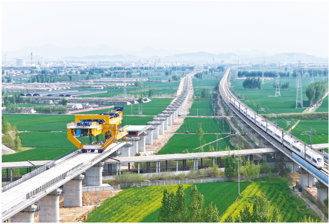
4月15日，济枣铁路成功上跨瓦日铁路。
