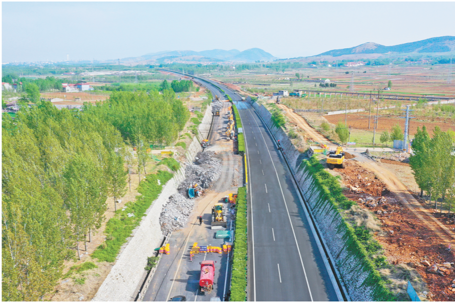
4月12日，泰新高速徂徕枢纽至新泰枢纽段改扩建项目桥梁拆除施工现场。
