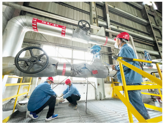
对重点客户中粮公司开展管线巡检
