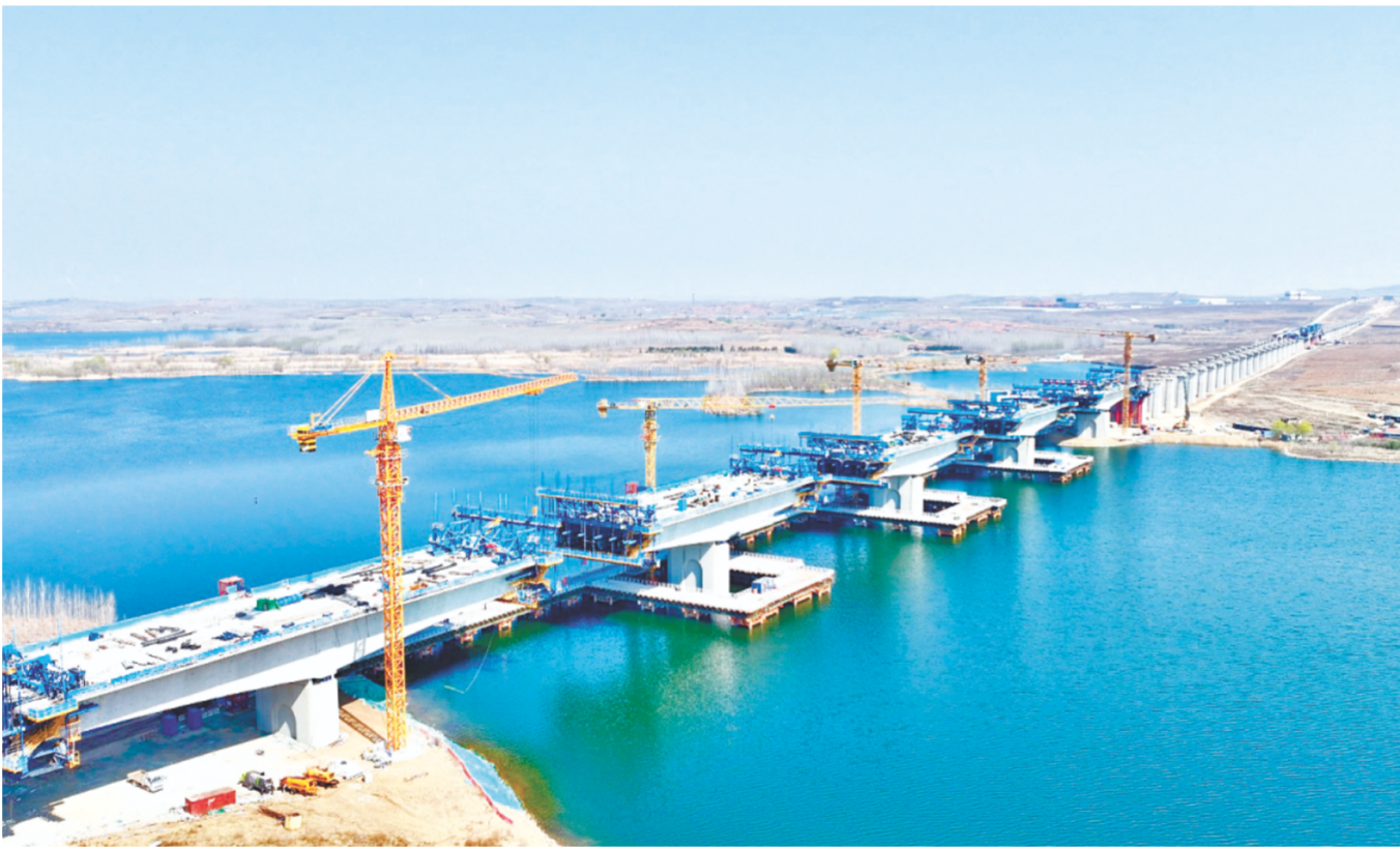
山东铁投集团济青高铁公司全力推进青岛连接线工程建设，关键节点及形象进度持续刷新。
