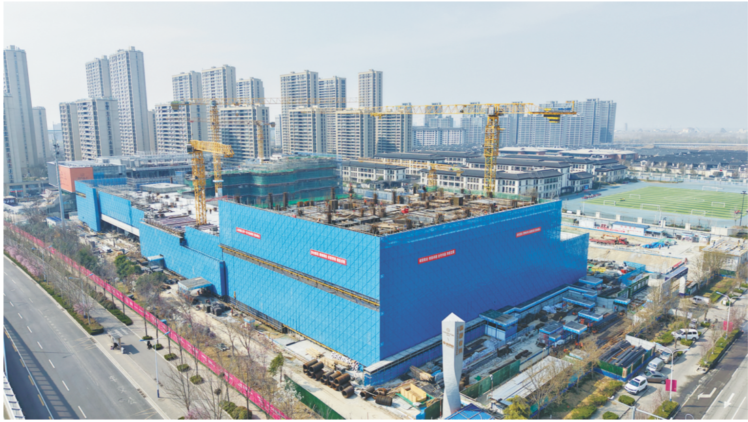
银泰百货项目主体结构已完成40%。
