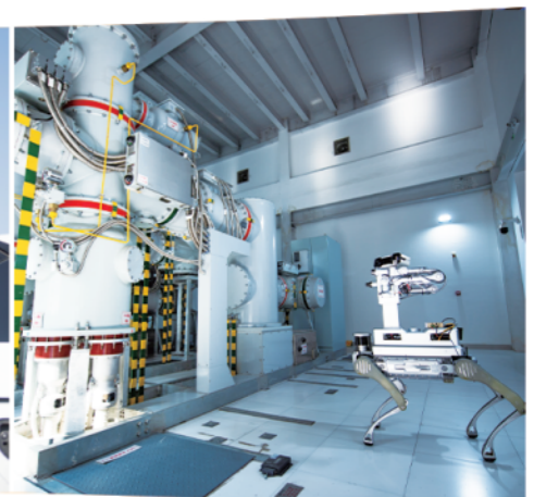
国网淄博供电公司依托巡检一体机器人开展变电站巡视
