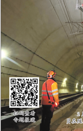
2月6日凌晨2点，青岛供电威海网工区工作人员在隧道内巡检。（□记者 许金星 报道）
