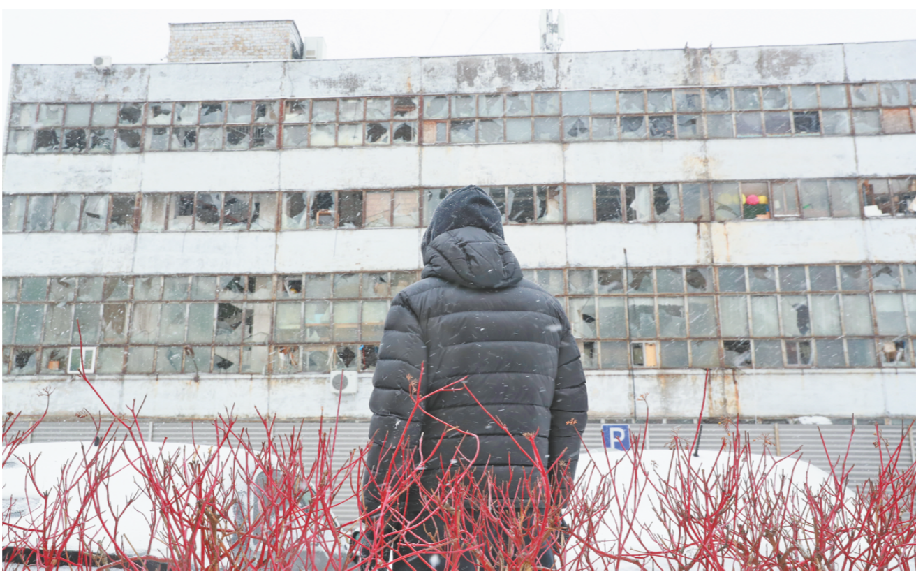
1月9日，一男子在乌克兰首都基辅市第聂伯区查看空袭中受损的建筑。(□新华社发)
