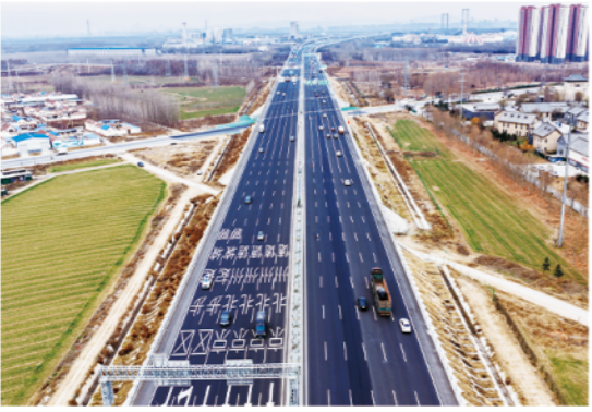
京台高速齐济段改扩建项目
