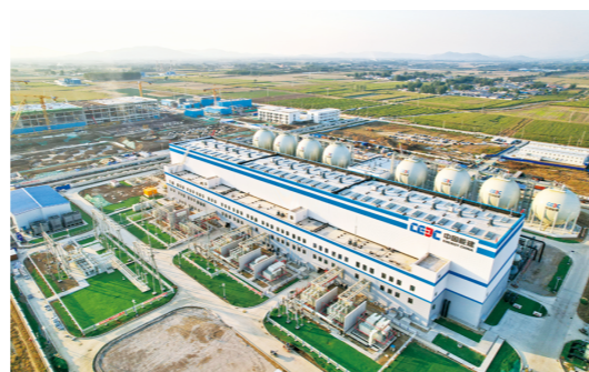
中能建350MW盐穴压缩空气储能项目
