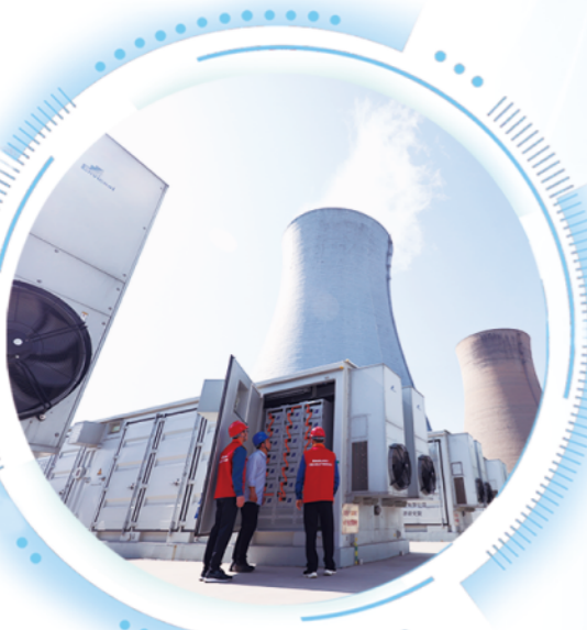
工作人员协助企业巡视检查化学储能电站内设备
