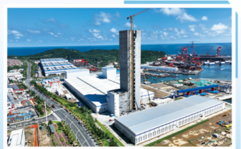
泰昇海底电缆项目
