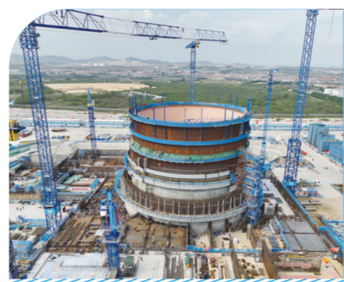
华能石岛湾核电基地扩建一期工程施工现场
