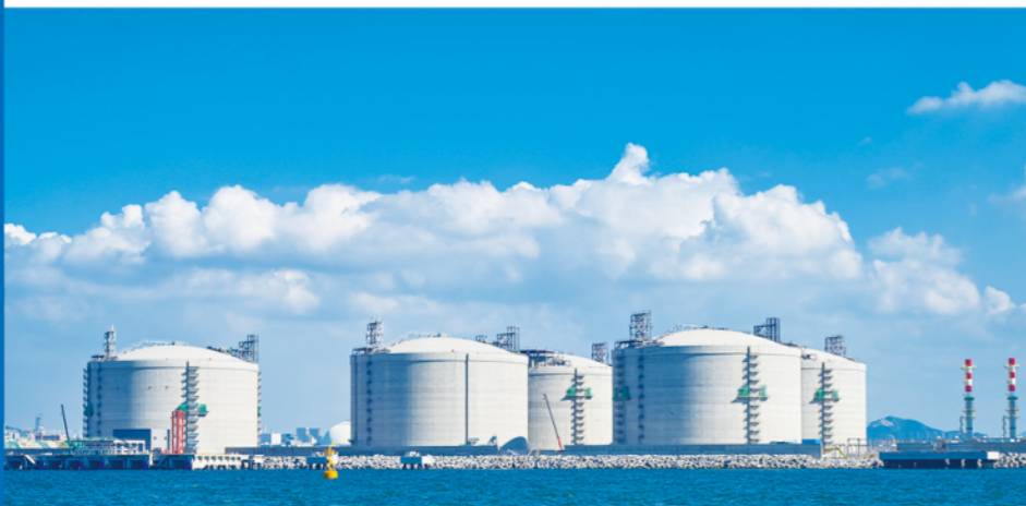
山东油气依托烟台港西港区LNG接收站建设的省级储气设施主体工程实现机械完工
