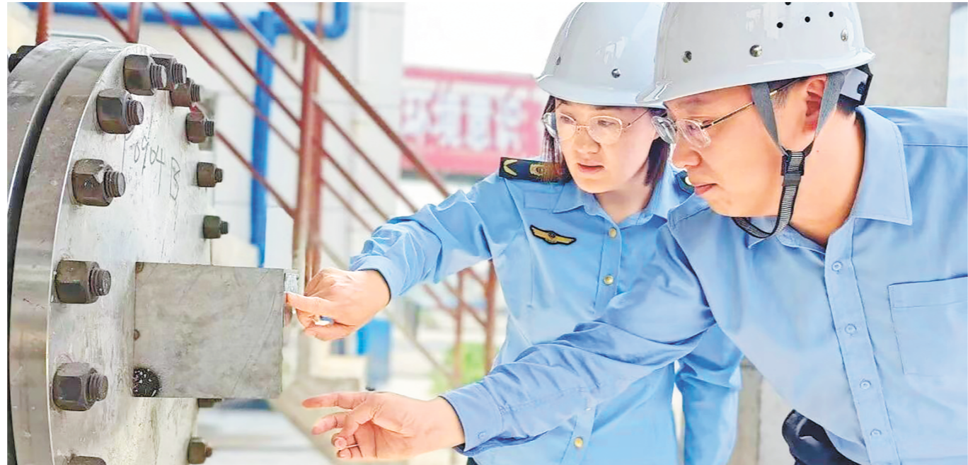
肥城市市场监督管理局聚焦化工领域特种设备安全,对泰安瑞赛昊环保科技有限公司开展特种设备专项检查,重点对压力容器、压力管道、锅炉等高风险设备进行全面“体检”和隐患排查。
