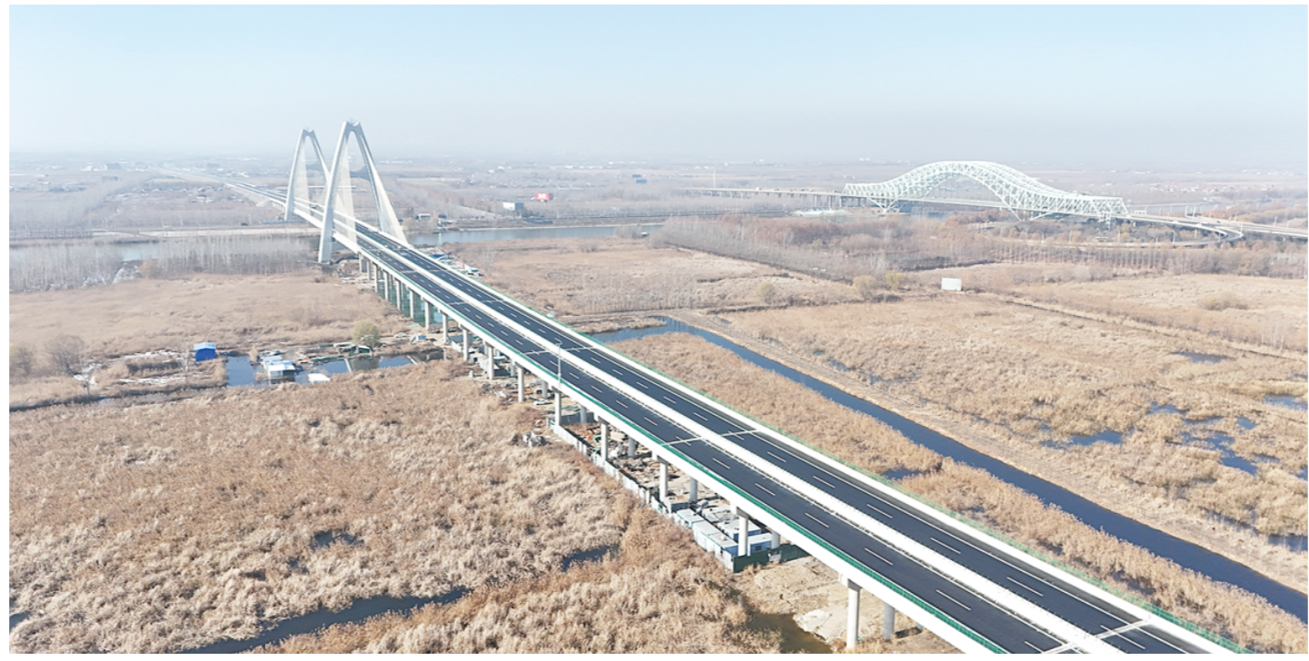
日前，济邹高速项目通过竣工验收，即将通车运营。济邹高速项目是山东省“九纵五横一环七射多连”高速公路网络布局中至关重要的一条连接线，项目的建设不仅是优化区域高速公路网结构，提升路网整体效率的关键举措，更是深度推进济宁市市区一体化融合发展、服务沿线产业升级与资源流通、改善民众出行条件的战略性基础工程。
