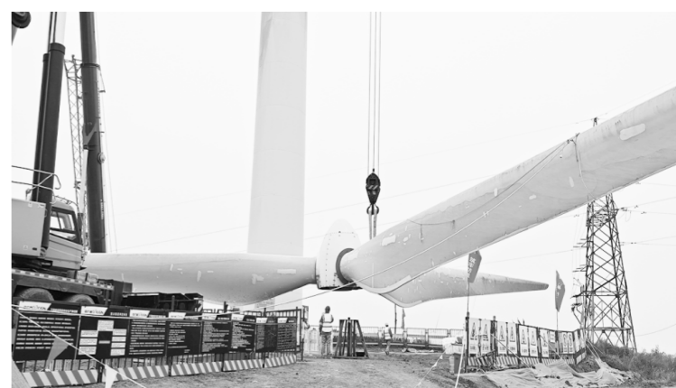
近日，在潍坊市中广核核能刘王庄风电场内，一台已持续运转15年的风电机组叶轮从60余米高空被缓缓吊下，这标志着一场由中车山东风电公司主导的“焕新”行动正式启动，这也是该公司在“以大代小”风电场改造领域的首个实践项目。（李娜）
