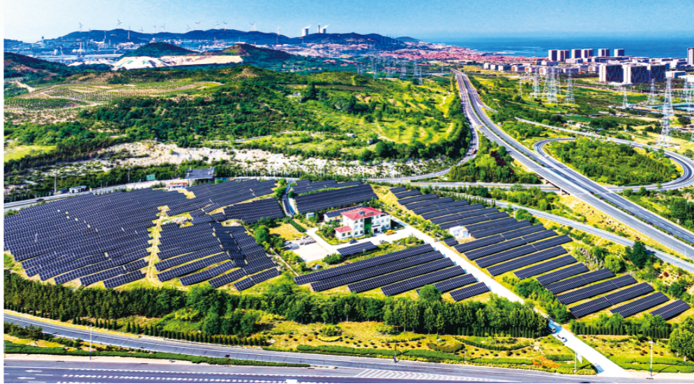
烟台福山区高速公路附近一处光伏示范基地
