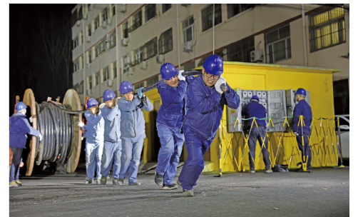
实施老旧小区户表改造工程
