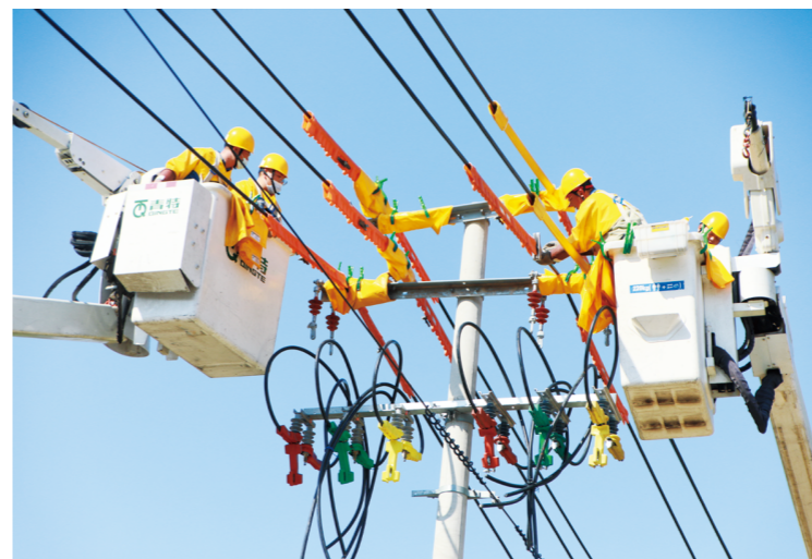
开展带电作业
