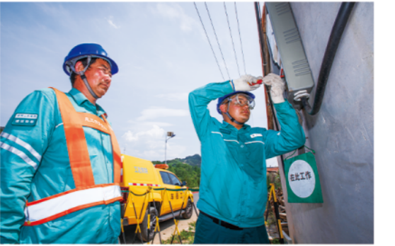
国网淄博供电公司工作人员为猕猴桃种植户更换漏电保护器 □摄影：远德亮
