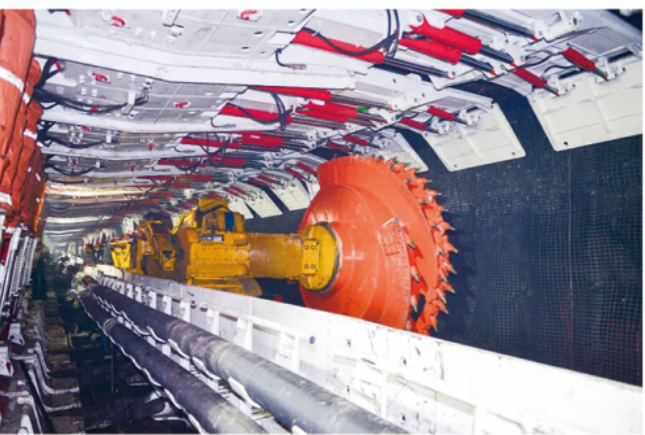
金鸡滩煤矿采煤工作面
