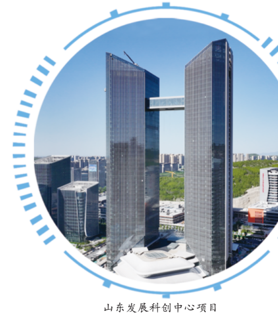
山东发展科创中心项目
