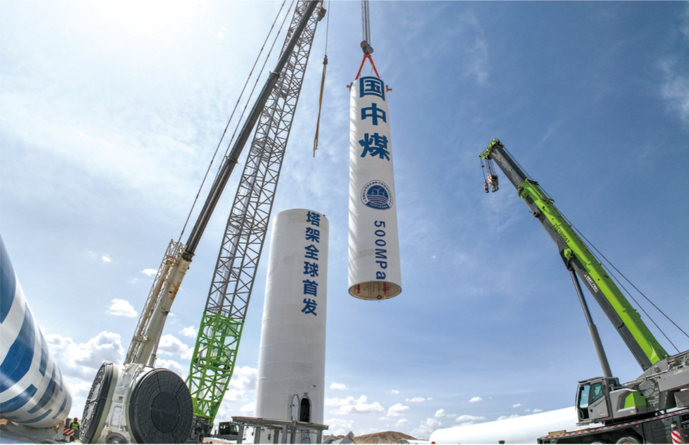
全球首台套500兆帕高强钢风电塔架吊装
