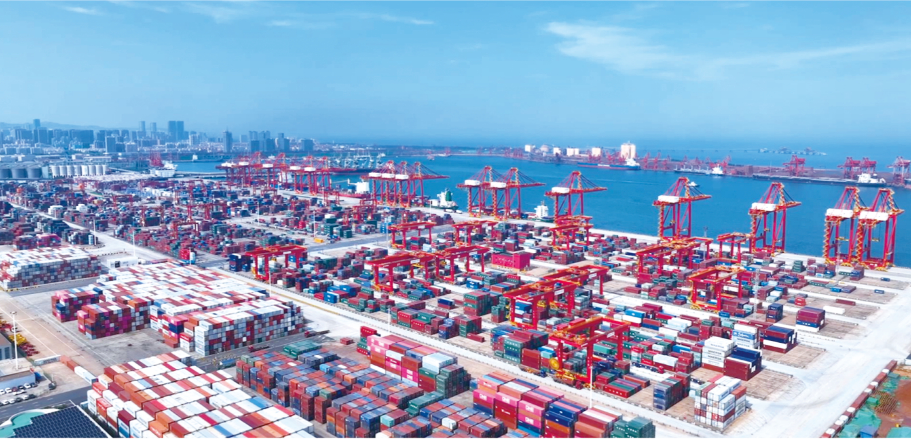
山东港口日照港全球首个顺岸开放式自动化集装箱码头作业现场
