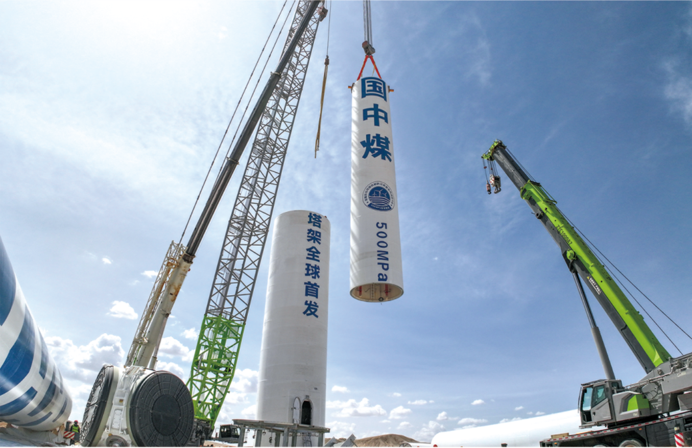
全球首台套500兆帕高强度风电塔架吊装
