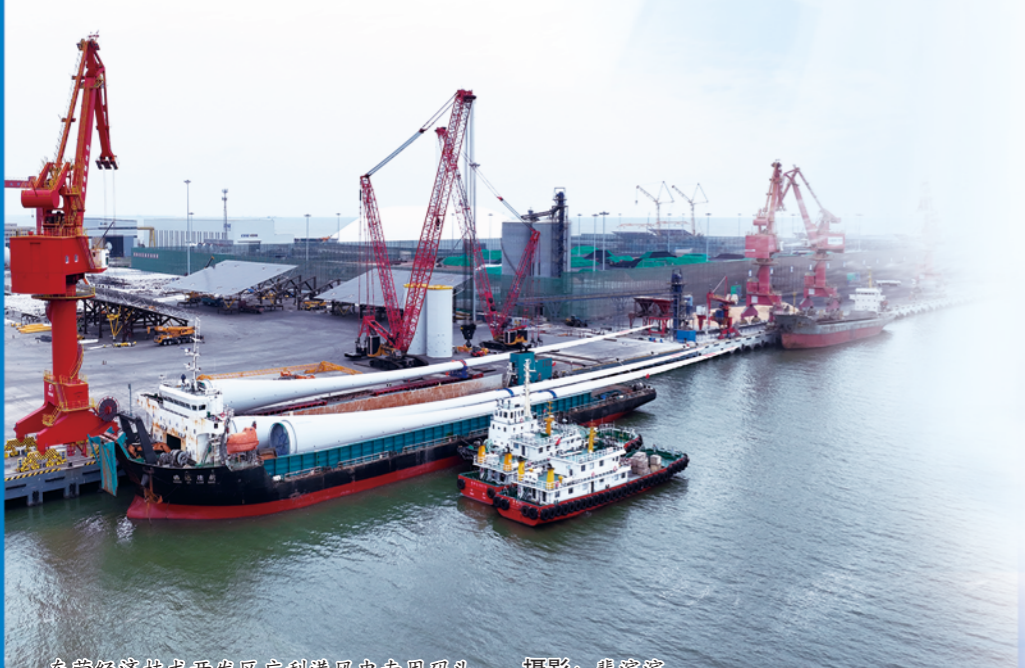
东营经济技术开发区广利港风电专用码头 摄影：裴滨滨
