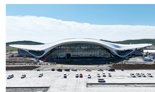
建设中的枣庄翼云机场现场，各类机械运转不停、工人忙碌作业，一派繁忙有序的施工景象 摄影：李宗完
