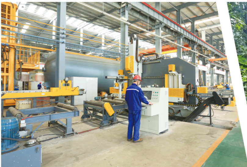
莱商银行信贷支持济南某新能源低热值煤清洁能源环保节能项目
