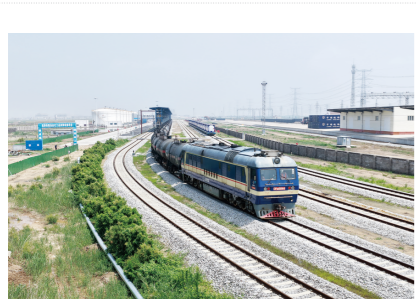
东营港疏港铁路
