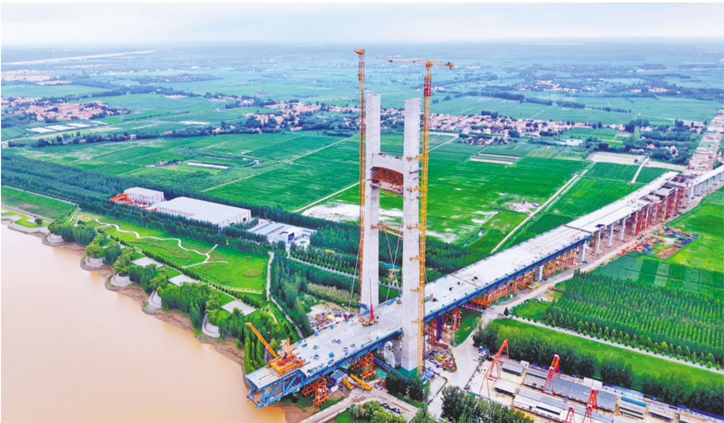
□ 记者 李明 通讯员 张飞翔 报道 近日，由中铁大桥局承担施工的津潍高铁东营黄河公铁大桥首对斜拉索顺利完成挂设。
