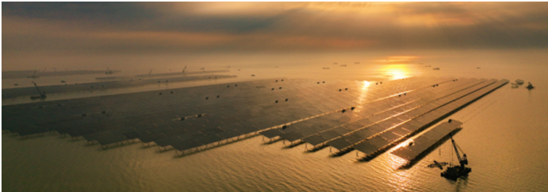
一排排光伏板在海洋上延伸，将无尽阳光转化为清洁电力。
