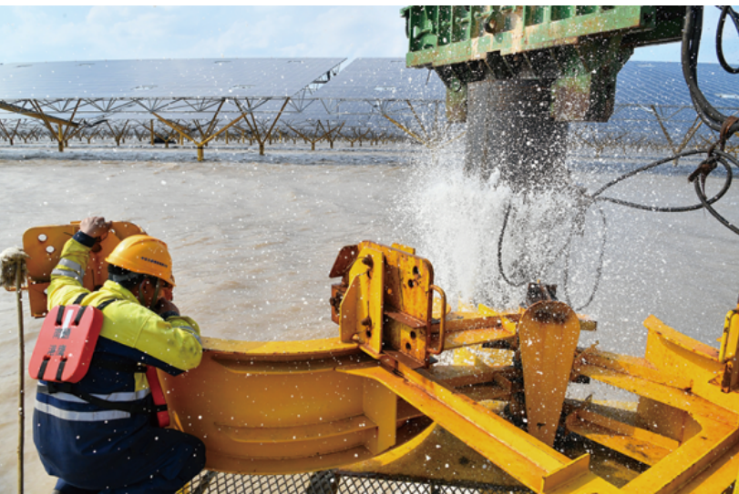
沉桩时，工作人员目不转睛地看着水平仪，确保精确到厘米级。
