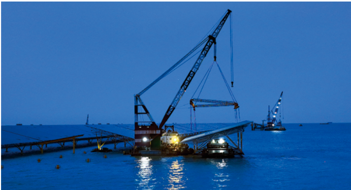
海上施工作业采用倒班制，24小时不停工。
