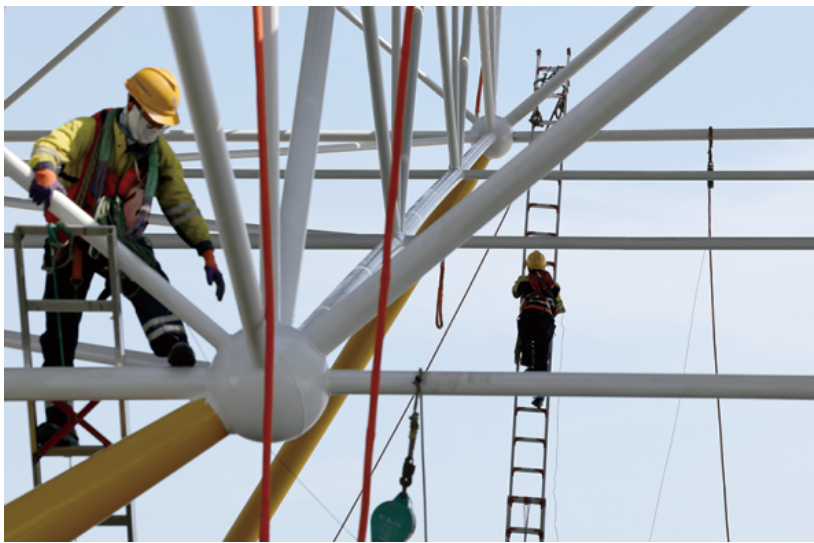
工作人员在安装海上光伏平台。
