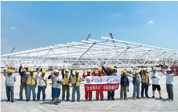
在中交三航局国华HG14海上光伏施工二标段项目部施工现场，本报记者和作业人员合影。
