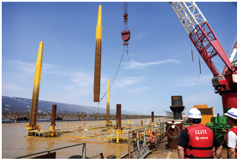
振动锤将一根根管桩笔直地沉入海水中。
