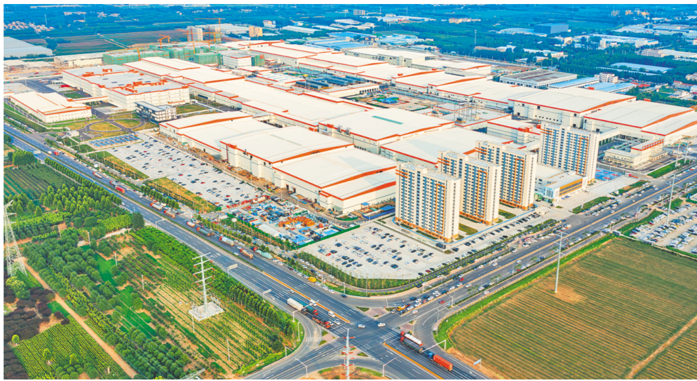
山东时代新能源电池生产基地致力于生产全球领先的储能和动力电池,目标直指打造中国北方规模最大的新能源电池产业高地。图为生产基地外景。
