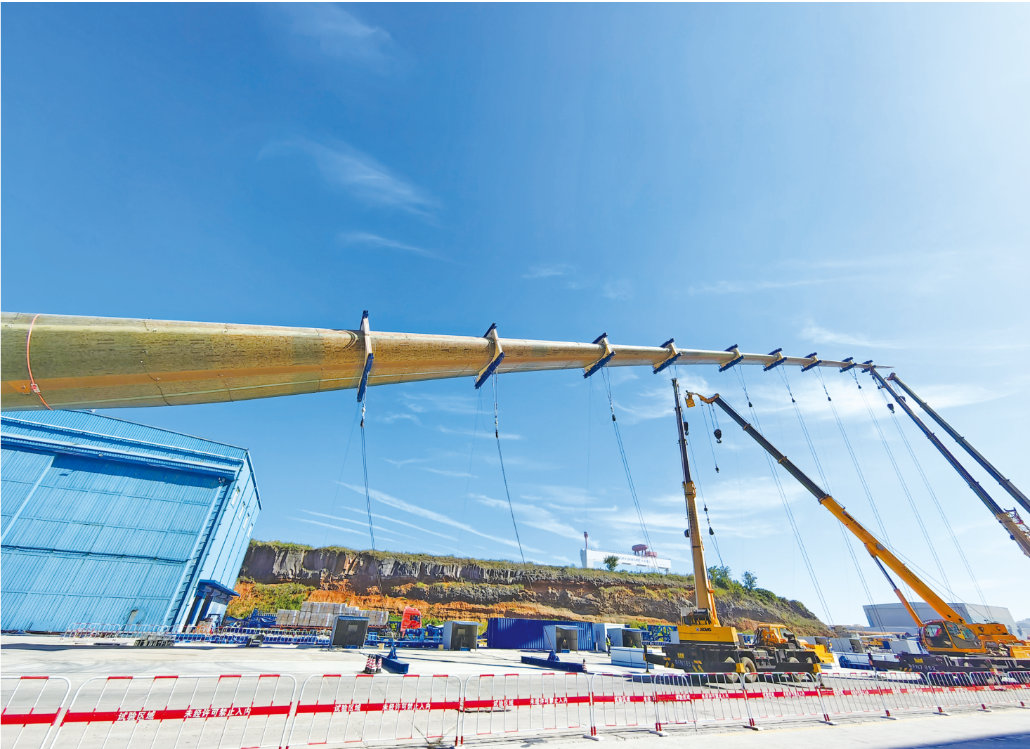
图为风机叶片在进行静力测试。
