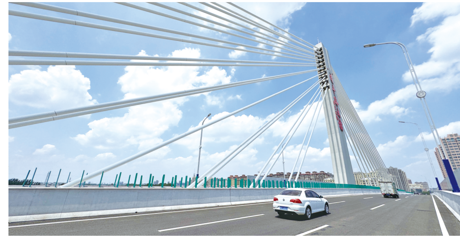
“十四五”期间,潍坊市城市建设日新月异。图为6月30日,潍坊市清平路跨铁路立交桥主桥正式通车。清平路跨铁路立交桥工程为全国最重单体系塔斜拉桥。
