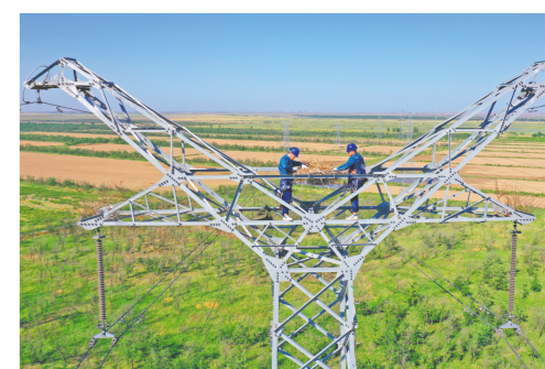
国网东营供电公司输电人员在220千伏海港1、II线14号铁塔为东方白鹳搭建人工鸟巢。(□记者 刘童 通讯员 李恒发 报道)
