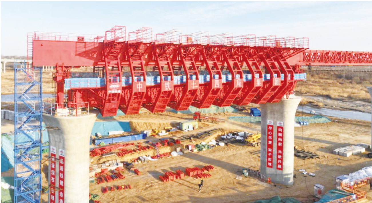
▲ 中铁十四局承建的潍宿高铁站前二标项目施工现场。
