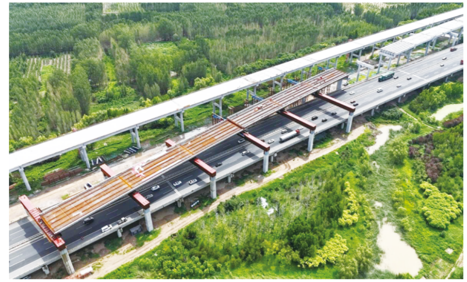
京台高速齐济段改扩建项目现场
