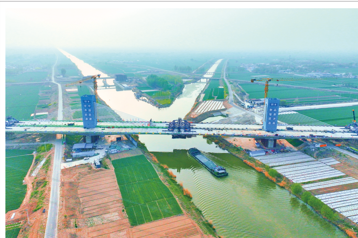
4月10日，济宁至商丘高速公路新万福河特大桥主跨顺利合龙，比预定工期提前了4个月。新万福河特大桥位于金乡县羊山镇，为双塔单索面预应力斜拉桥，桥梁全长882米，桥面宽35.5米，主塔高度32米，结构体系为塔梁固结、塔墩分离体系。新万福河特大桥的合龙标志着济商高速项目建设取得重大突破，为全线完工通车创造了有利条件。
