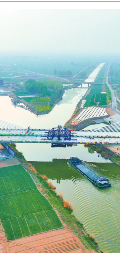
4月10日，济宁至商丘高速公路新万福河特大桥主跨顺利合龙，比预定工期提前了4个月。新万福河特大桥位于金乡县羊山镇，为双塔单索面预应力斜拉桥，桥梁全长882米，桥面宽35.5米，主塔高度32米，结构体系为塔梁固结、塔墩分离体系。新万福河特大桥的合龙标志着济商高速项目建设取得重大突破，为全线完工通车创造了有利条件。
