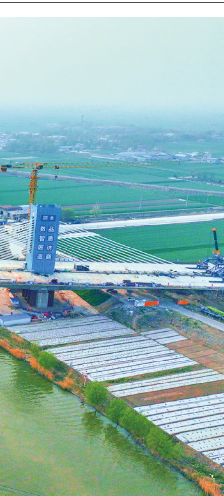
4月10日，济宁至商丘高速公路新万福河特大桥主跨顺利合龙，比预定工期提前了4个月。新万福河特大桥位于金乡县羊山镇，为双塔单索面预应力斜拉桥，桥梁全长882米，桥面宽35.5米，主塔高度32米，结构体系为塔梁固结、塔墩分离体系。新万福河特大桥的合龙标志着济商高速项目建设取得重大突破，为全线完工通车创造了有利条件。
