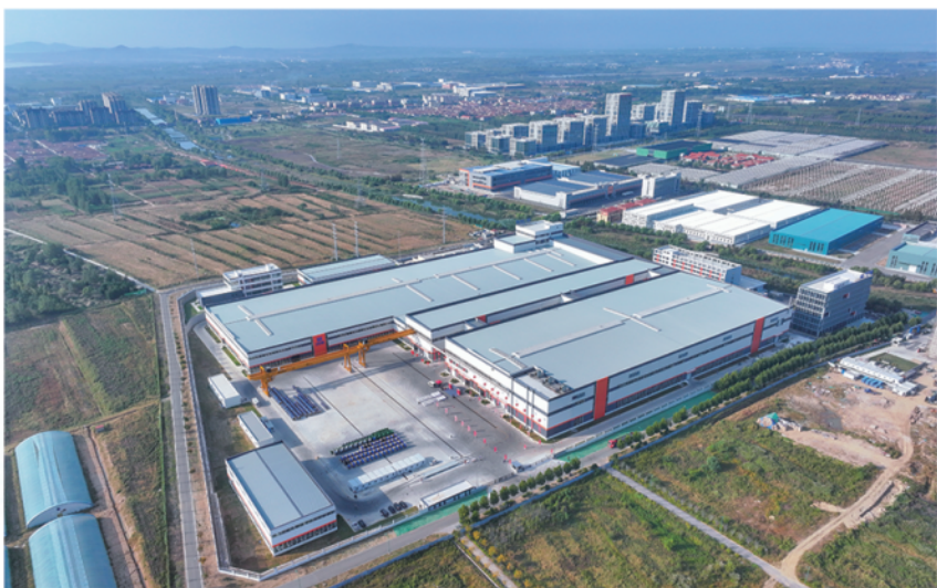
万马高端装备产业园
