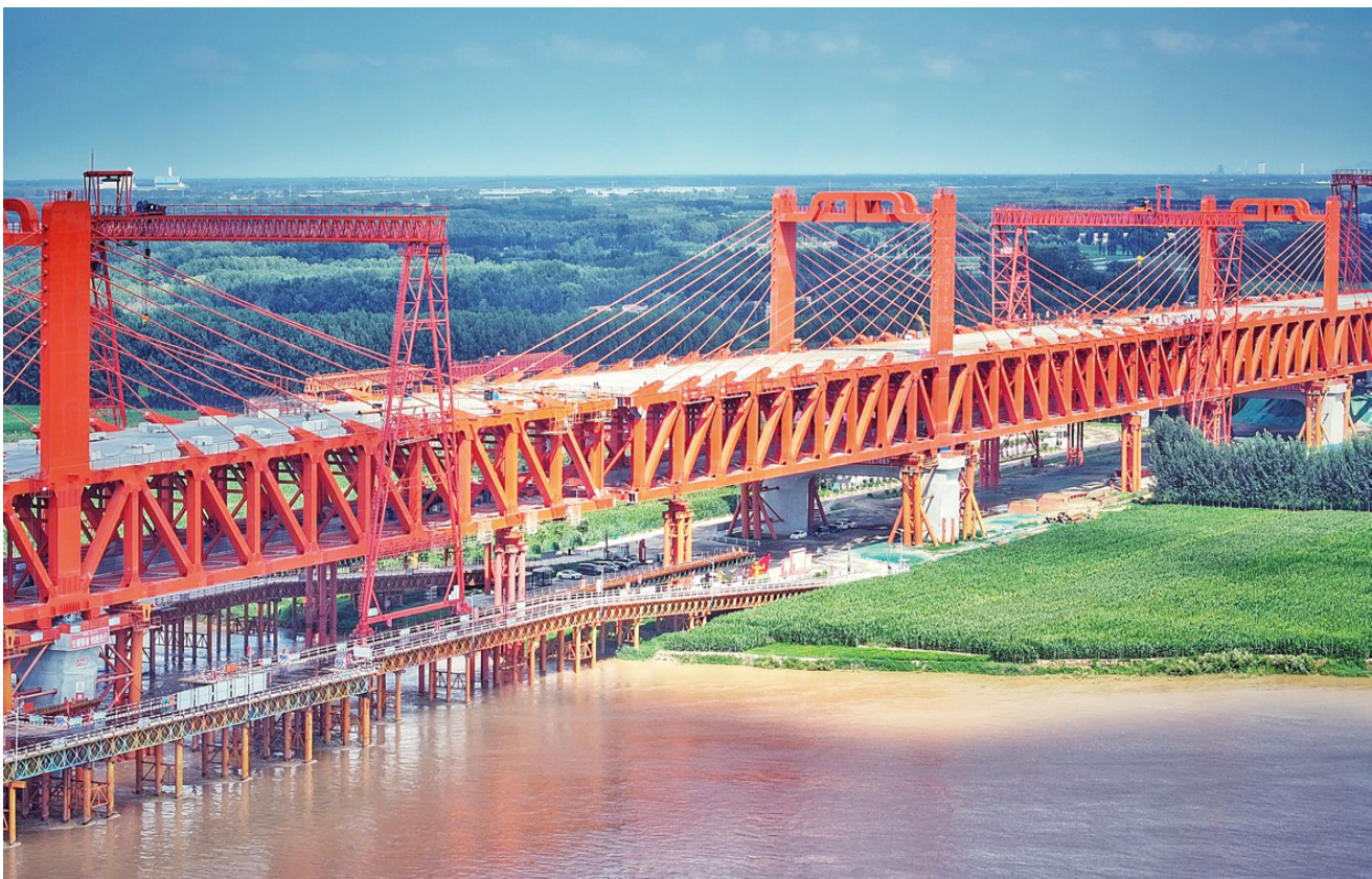
不负春光保工期,济滨高铁建设现场机械轰鸣,一派繁忙景象。济南至滨州高铁是山东半岛城市群构建“四横六纵”现代化高铁网络的重要组成部分,预计2026年底建成通车。(口记者 常青 报道)
