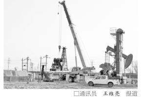
近日, 胜利油田东辛采油厂营二管理区, 员工正 在对作业完井后的营12检176井安装抽油机。
