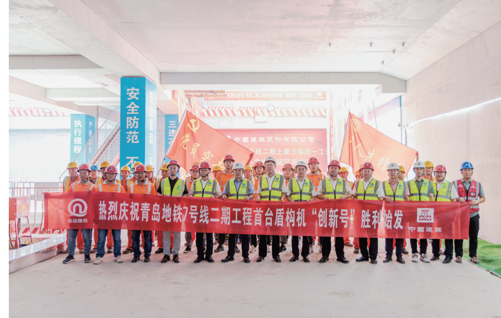
青岛地铁7号线二期工程首台盾构机始发现场
