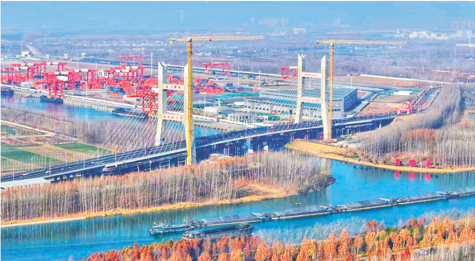
近日，济宁运河大道暨龙拱港特大桥通车，标志着济宁城市“西跨”再迈一步。
