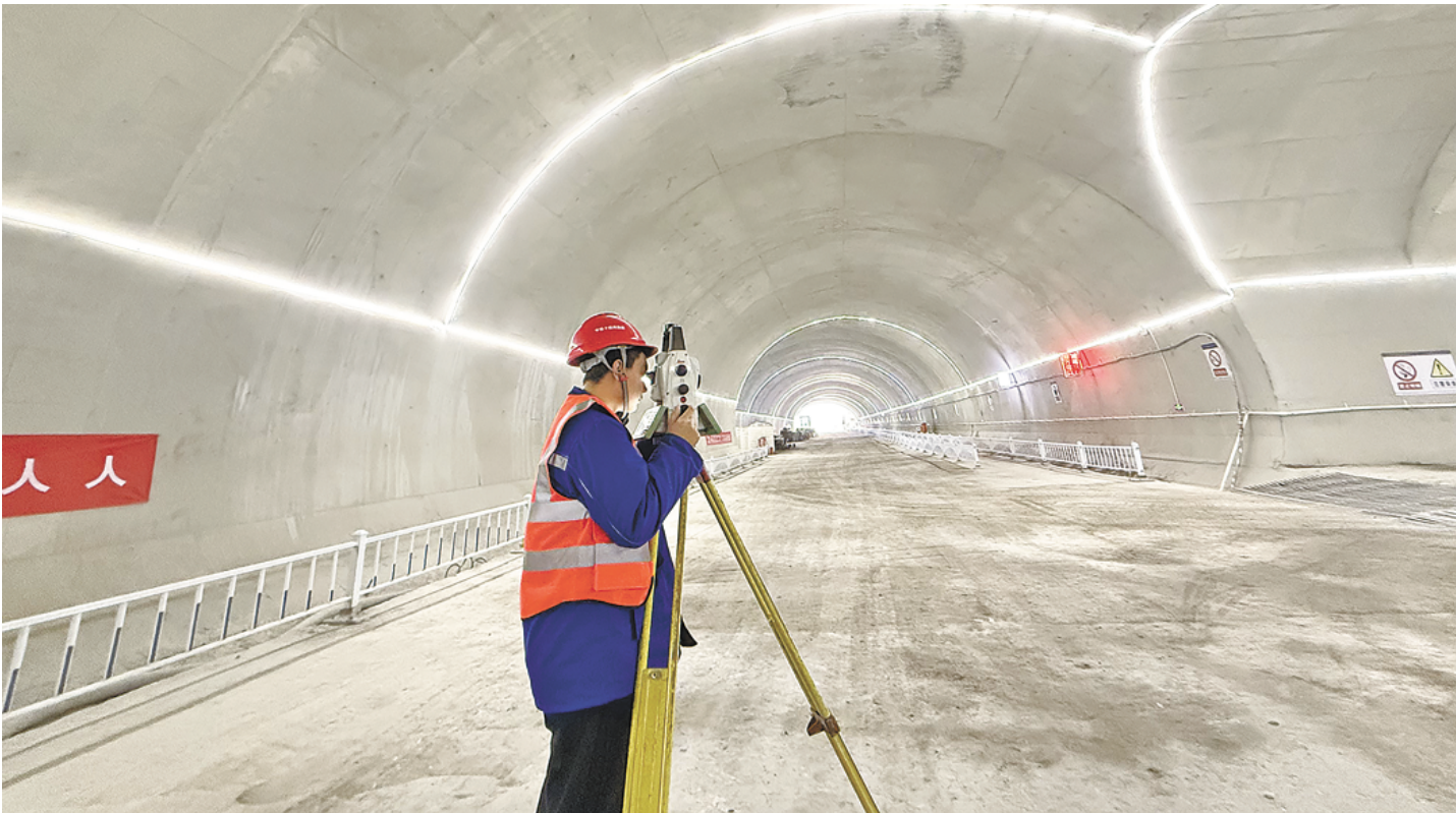
工作人员在进行微震监测作业。
