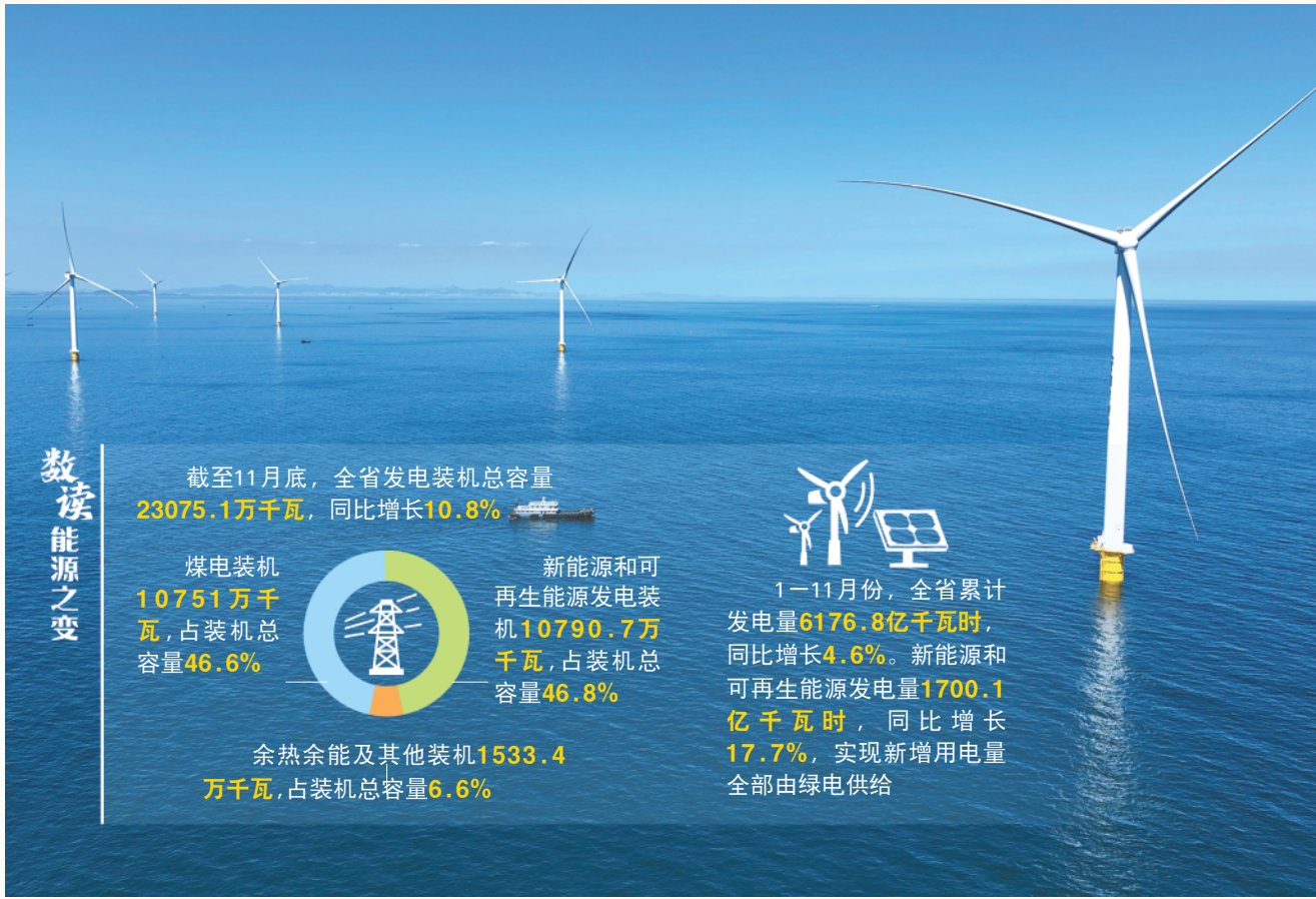
山东半岛南U1场址海上风电项目。
