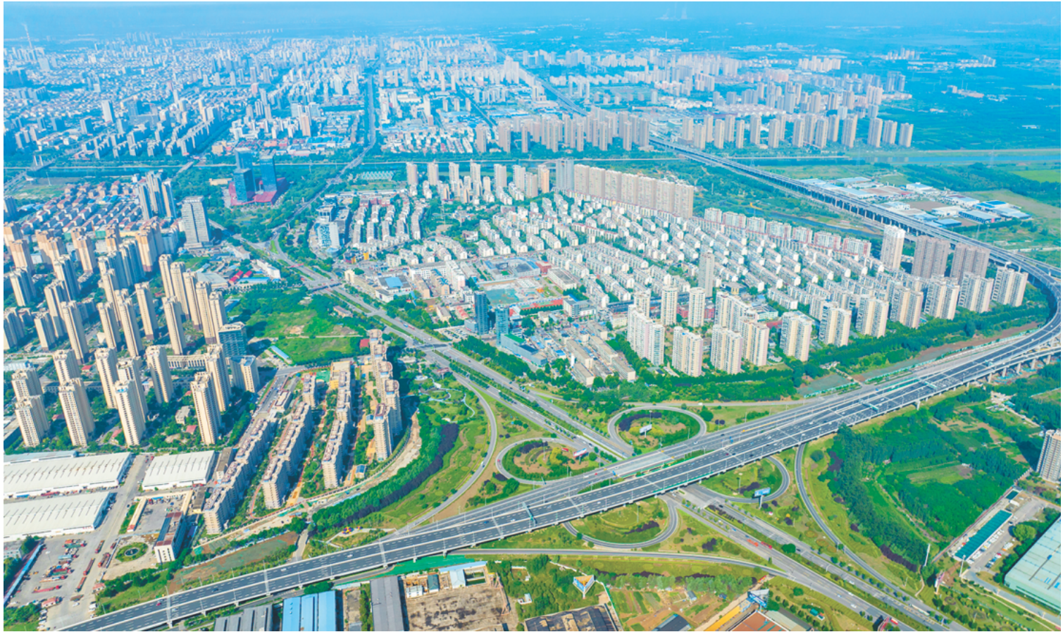
图为济宁主城区内环高架柳行立交。
