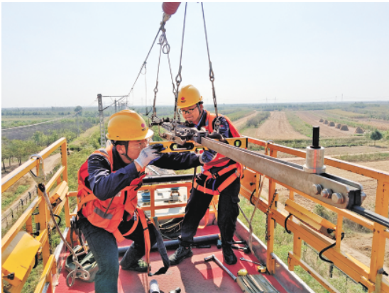
□记者 李明 通讯员 文媛媛 报道 进入秋季，中铁十五局集团轨道交通运营公司黄大分处紧盯季节性安全问题，有序开展设备秋检秋鉴，进一步加大安全工作力度，确保黄大铁路运输安全稳定。图为公司供电专业网电工对分相绝缘器进行检修。
