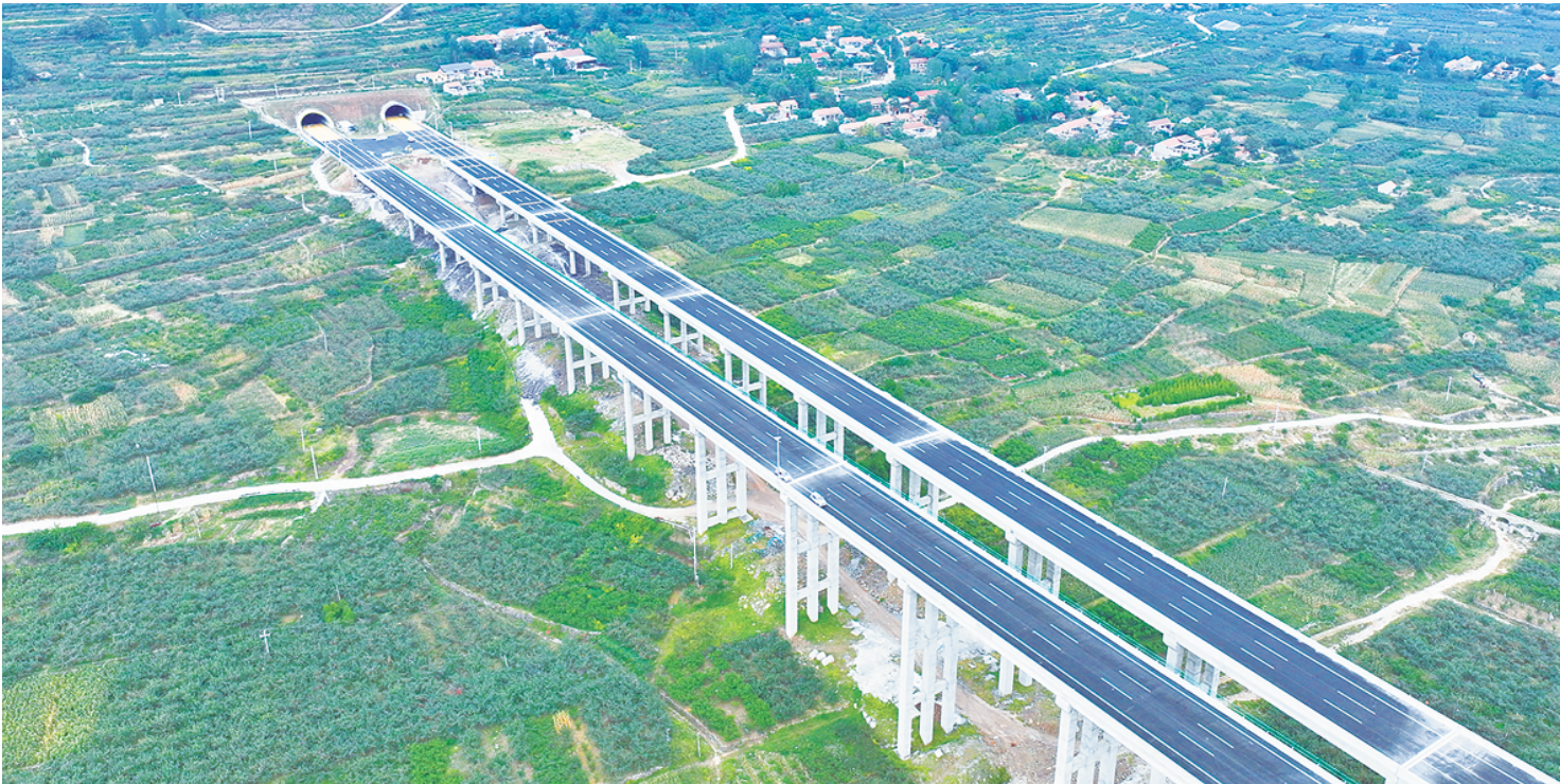
临临高速本月全线贯通。
