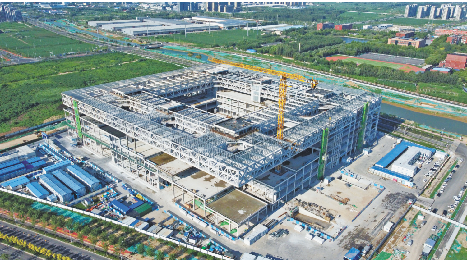
济南起步区新能源新材料产业园基础设施项目C-2地块已完成主体建设，计划2025年5月底竣工。该项目是为机器人、空天先进装备创新基地等未来产业领域项目打造的“平行世界”。
